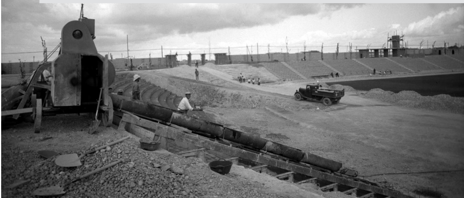
Cubiertas y Tejados fue la empresa encargada de la ejecución de las obras.
