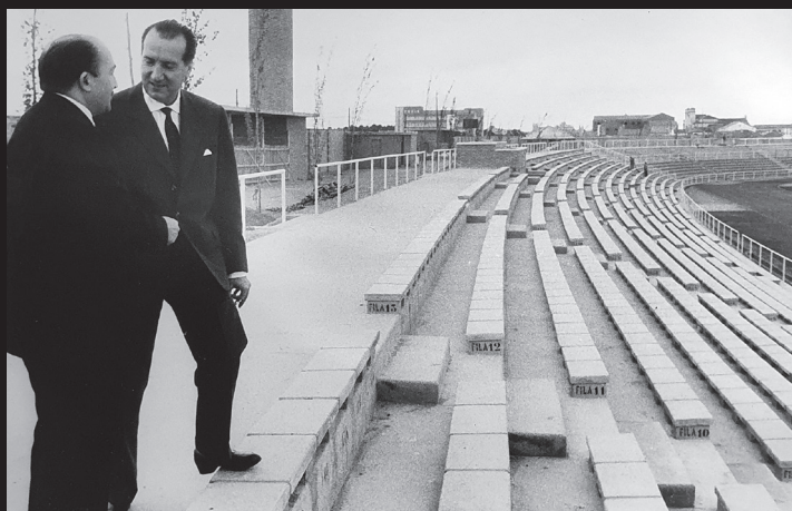
El Ministro de Educación Nacional, Jesús Rubio, visita las instalaciones del Estadio, aún en obras, en compañía del alcalde Carlos Belmonte.
