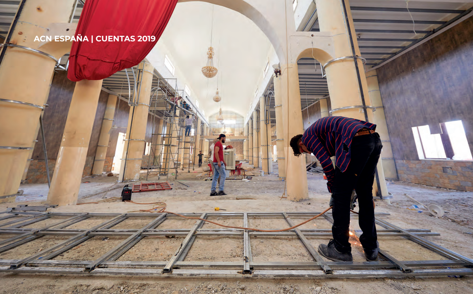
Reconstrucción de la parroquia de San Jorge en Teleskuf, Irak. © Jaco Klamer
